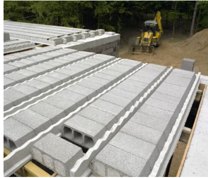
Fot.1 Die vorgespannten Fertigteildecke mit Füllkörpern und vorgespannten Deckenbalken aus Spannbeton während der Herstellung.
